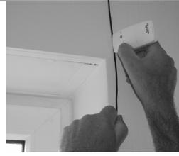
Einen ca. 50cm langen, isolierten Draht z.B. 1.5<sup>2</sup> über die Stelle halten, hinter der sich das SF19 befindet. Sender direkt an den Draht halten.
